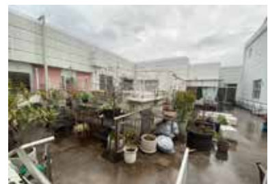
写10 従来型2階 中庭 汚物などを一時保管
