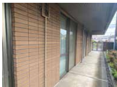
写8 1階のベランダ 幅が広く通りやすい
