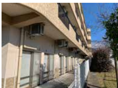
写1 外部から更衣室に入る
