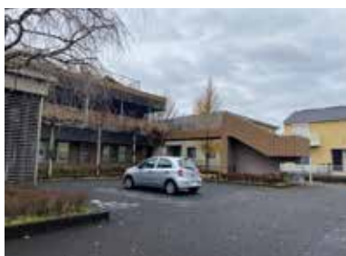
写7 玄関脇の非常階段
