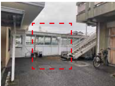
写 3-3 屋外に仮設の更衣室を設置 赤色の囲み部分に設置（C 施設）
